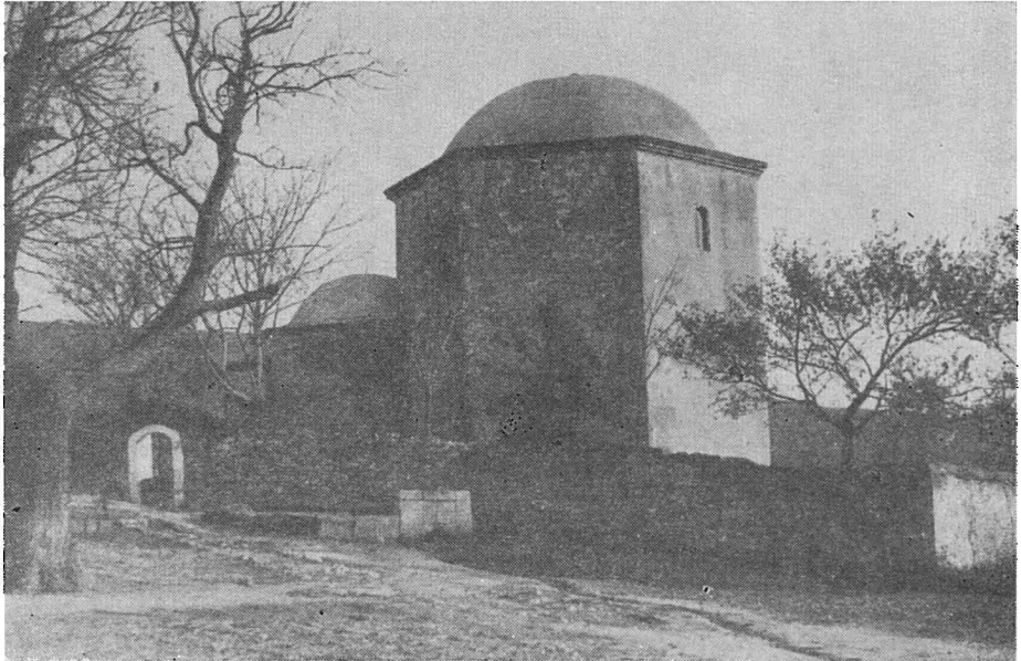
Fig. 2. — Edifice en pierre situé près du téké sur la vallée de la Batova
