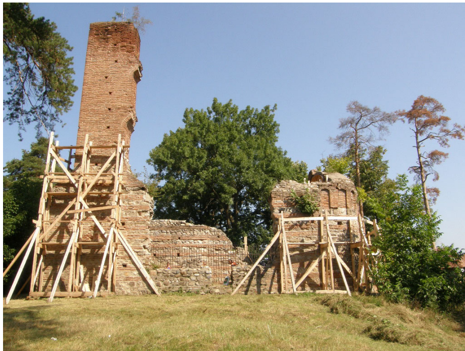
Fig. 2. L'église de Sân Nicoară – vue actuelle côté sud (photo S. Iosipescu, 2009).
